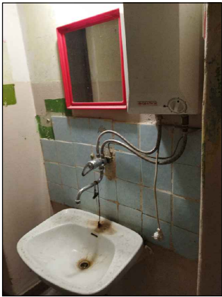
DEMONTÁŽ UMYVADLA DEMONTÁŽ SIFONU DEMONTÁŽ NÁST.NATERIE DEMONTÁŽ EL.ZÁS.OHŘÍVAČE
